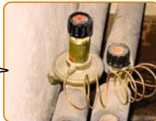
СОЕДИНЕНИЕ КЛАПАНОВ ИМПУЛЬСНОЙ ТРУБКОЙ
