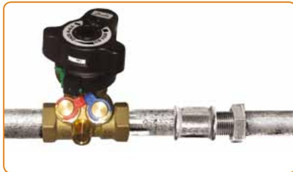
ПОСЛЕДОВАТЕЛЬНОСТЬ МОНТАЖА КЛАПАНОВ С НАРУЖНОЙ РЕЗЬБОЙ (С РЕЗЬБОВЫМИ ФИТИНГАМИ) НА ПРИМЕРЕ КЛАПАНА АВ-QM.
