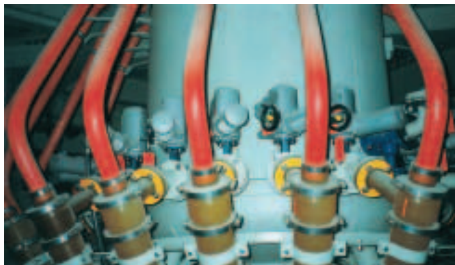
Неполнооборотные приводы AUMA на сероочистной установке электростанции.
