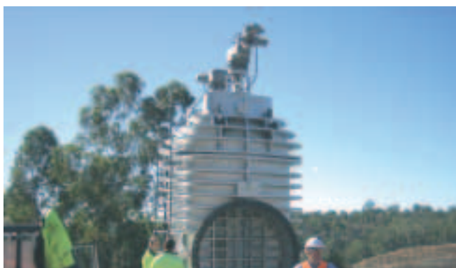
Задвижки с установленными на них приводами AUMA в рамках проекта строительства дамбы в Австралии.
